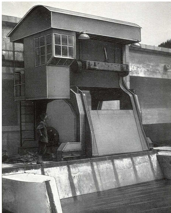
Slika 3: Čistilna naprava z grabilcem na vrveh
