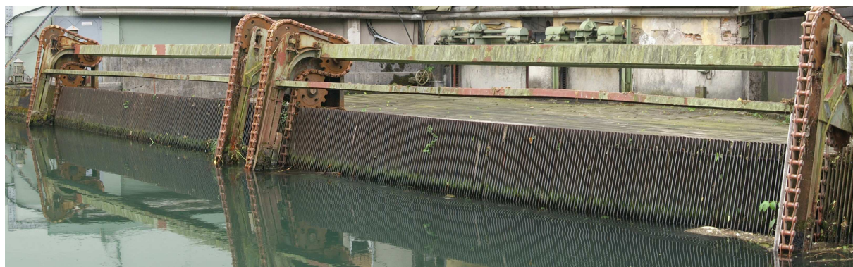
Slika 7: Vgradnja dveh verižnih čistilnih strojev širine 2 x 8 m
