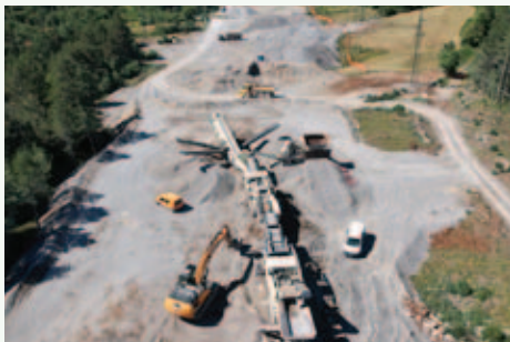
Drobilec - apnenec iz izkopa se loči in predela ter kasneje uporabi pri betonerskih delih. Foto: Andraž Gregorič
