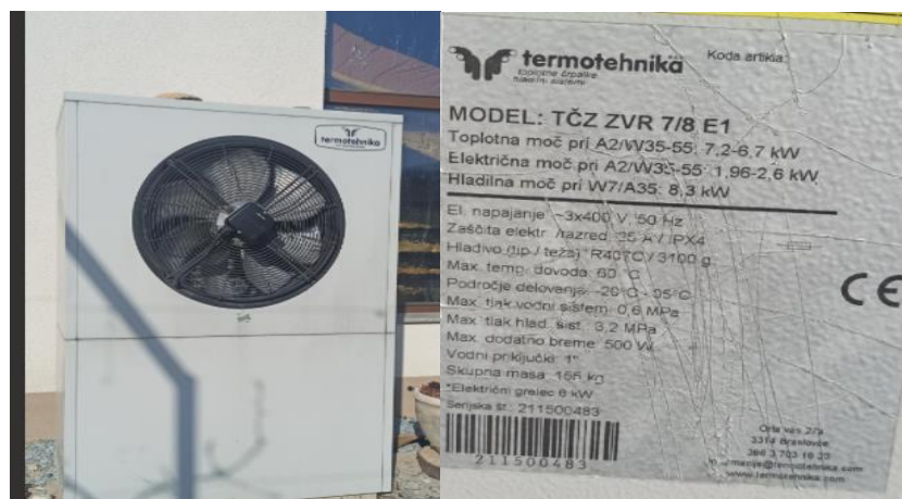
Slika 7: Uparjalnik TČ ZVR Kronoterm, 7 kW in nalepka s podatki TČ (lasten vir)
