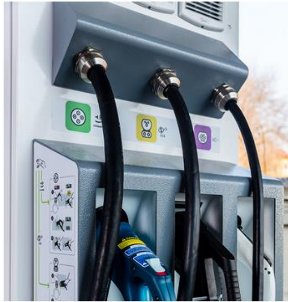
Slika 3: Polnilnica električnih vozil (EV) z različnimi vrstami priključev napajanja
