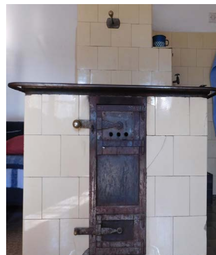
Slika 2: Zidan štedilnik Vir: Lasten (Kmetija pr' Jereb, 2022)
