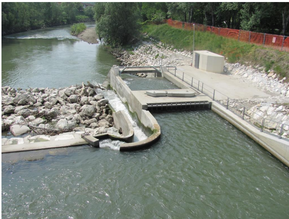
Slika 1: Elektrarna 500 kW, h=3\text{m} , Q=20\text{m}^3/\text{s} , VLH Montodine, Italija Vir: Jurij Čadež
