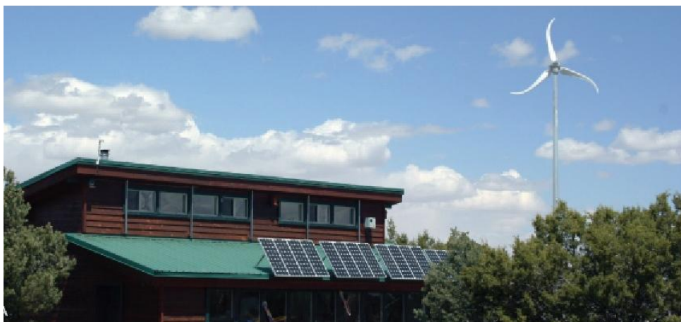
Slika 2: Urbana vetrna turbina moči 2,4 kW, radija 1,8 m, stolpa 8 m in letno proizvodnjo 5,4 MWh, življenjsko dobo nad 25 let in garancijo 5 let (Xzeres http://www.xzeres.com/wind-turbine-products/ )
