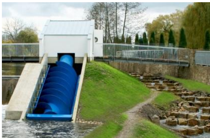
Slika 1: Mala HE s hidrodinamičnim vijakom za padec reke 1,8 m in pretok 0,5 \text{ m}^3/\text{s} (proizvajalec Andritz, http://www.andritz.com/oi-atro-hydrodynamic-screws-en.pdf )
