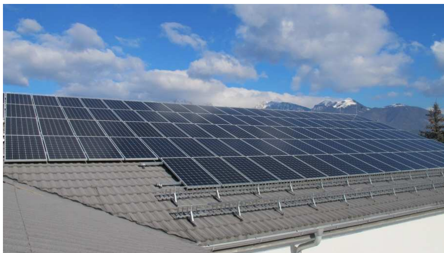
Slika 16: Dodatna dvojna zaščita s snegolovi Vir: Arhiv Gorenjske elektrarne
