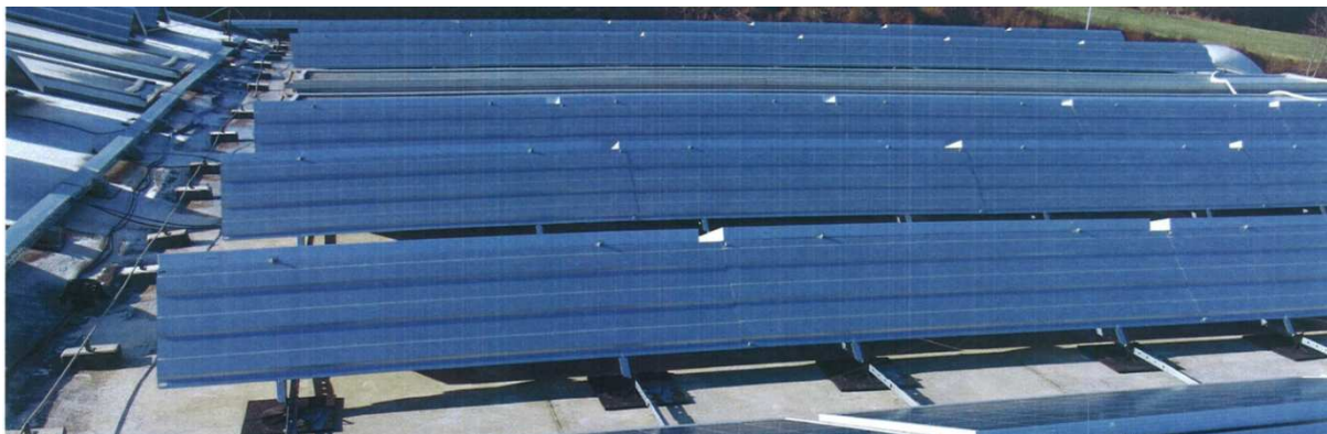
Slika 10: Primer postavitve konstrukcije na strehi Merkurja (pogled na deflektorje) Vir: arhiv Gorenjske elektrarne
