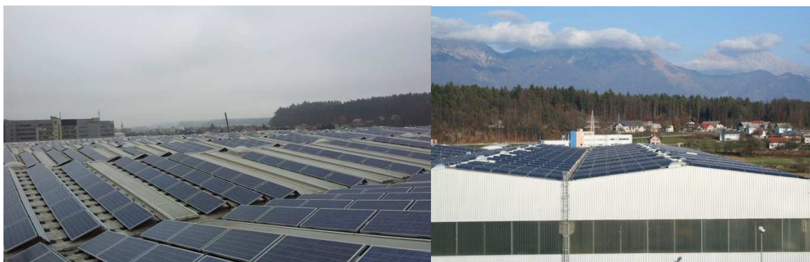
Slika 11, 12: izvedba sončne elektrarne Merkur s sistemom TectoFlat Vir: Arhiv Gorenjske elektrarne
