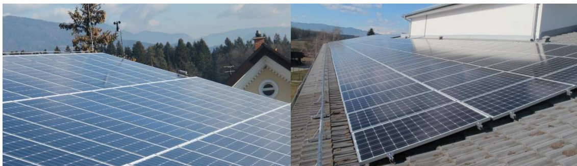
Slika 14, 15: »Žagasta« postavitve modulov na strehi OŠ Šenčur Vir: Arhiv Gorenjske elektrarne
